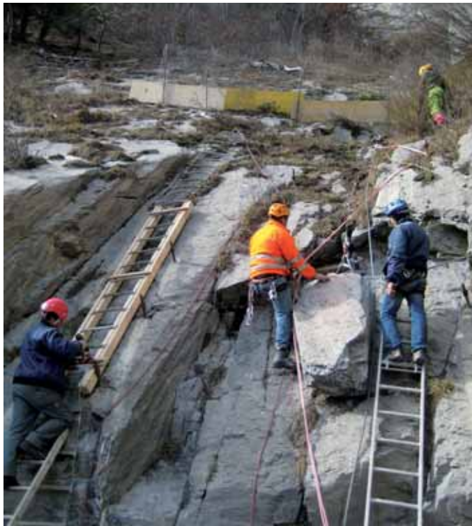
Bild 10. Einrichten der Versuchsanlage.
