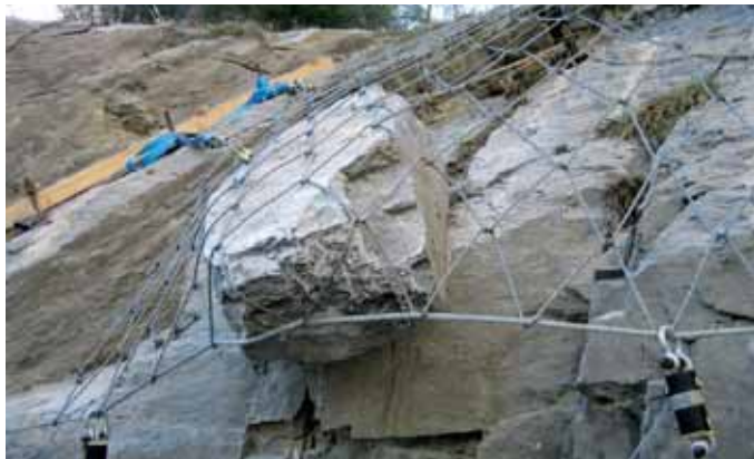
Bild 12. Versuch zur Untersuchung des Einflusses des Randseils auf das Tragverhalten und die Kräfte.
