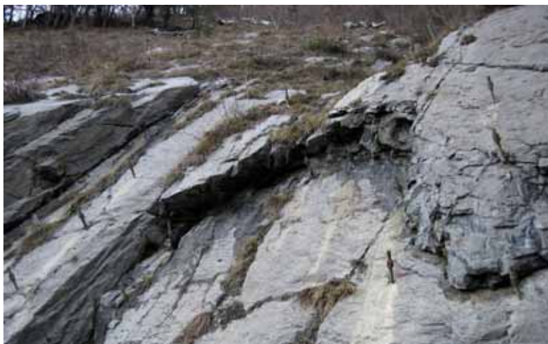
Bild 6. Anordnung der Verankerungen.
