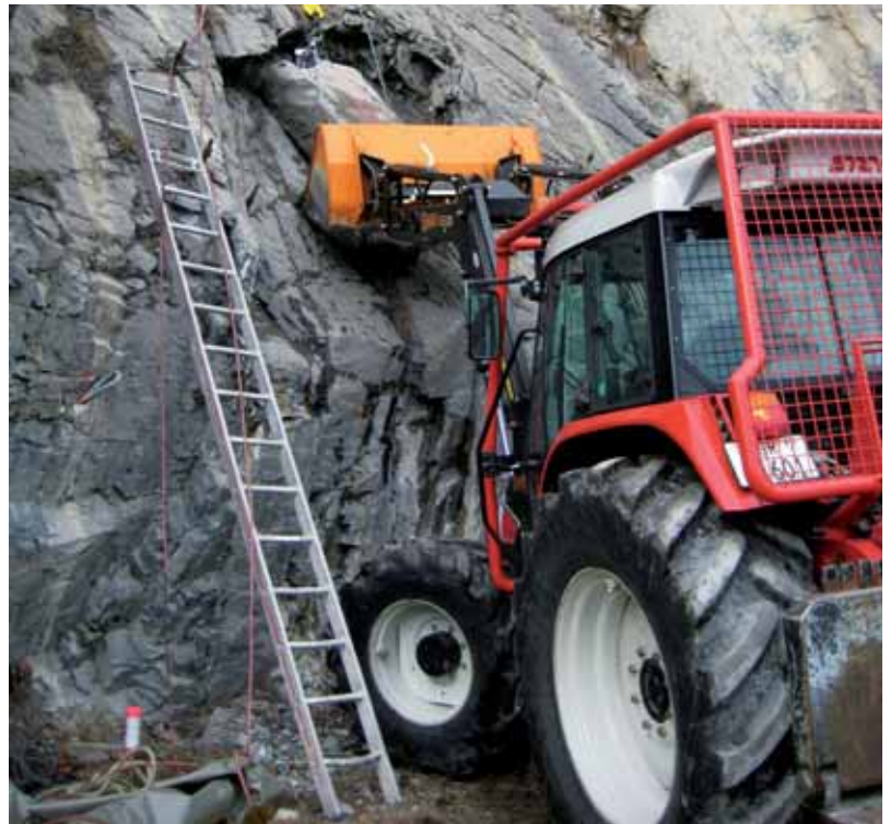
Bild 8. Positionierung des Versuchsblocks.
