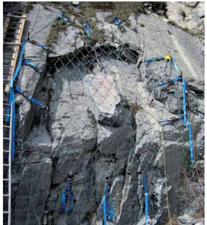
Bild 11. Gesamtansicht der Versuchseinrichtung ohne Berücksichtigung eines Randseils.
