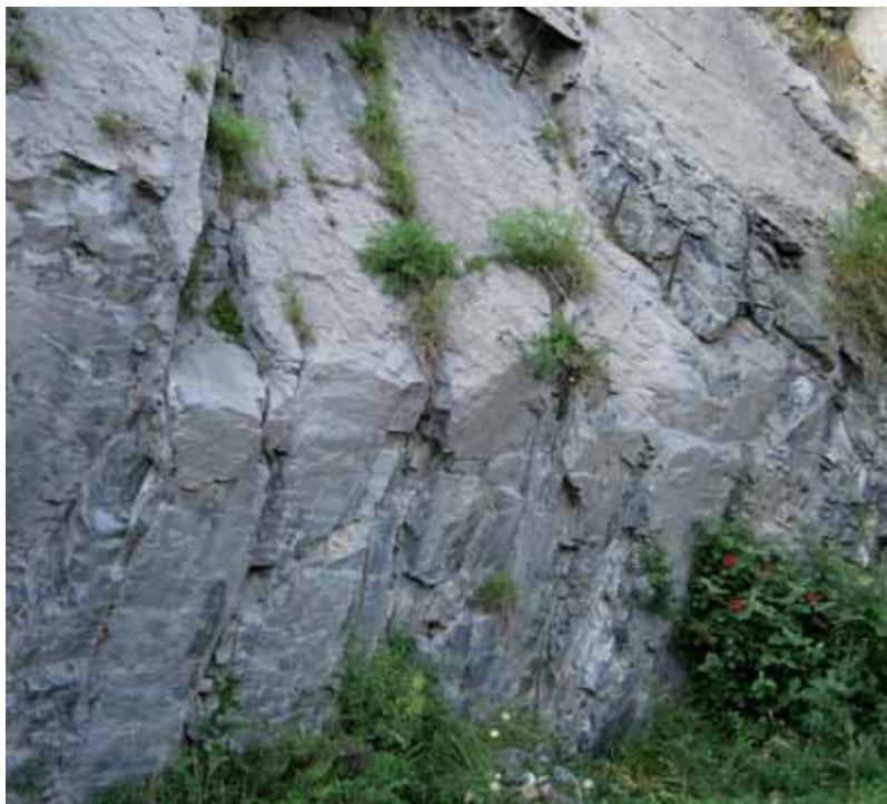
Bild 5. Ausbruchnische als Versuchsgelände.
