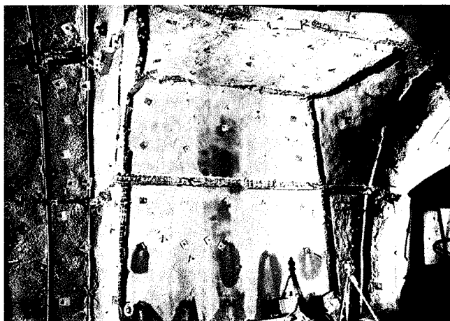
Bild 3 Aufgelöste Spritzbetonsicherung im Bereich der Radabspannsiche.
