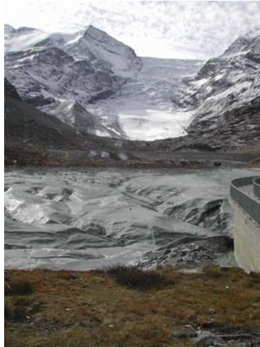
Abbildung 9: Absperrbauwerk der Anlage Tourtemagne mit dem verlandeten Speicher
