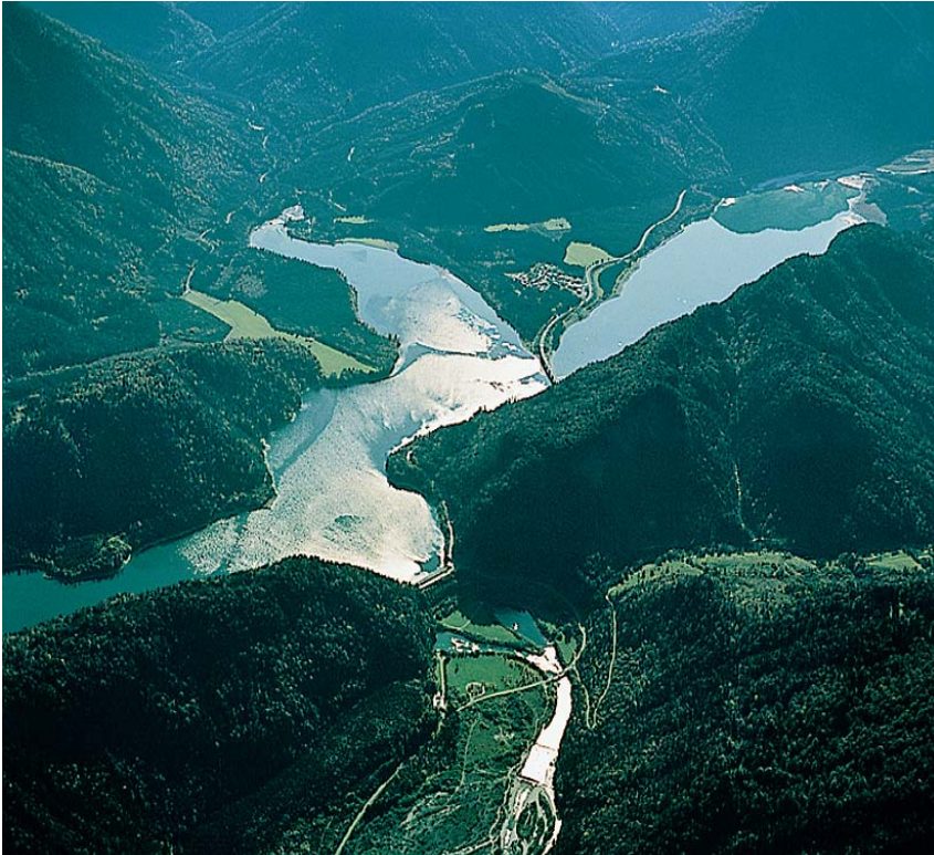
Abbildung 8: Ansicht Speicher Sylvenstein mit dem Abschlussbauwerk (Quelle: Wasserwirtschaftsamt Weilheim)
