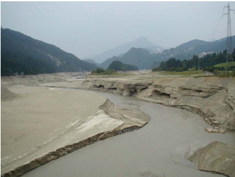
Abbildung 12: Anlandungen im abgesenkten Speicher Pieve di Cadore (Quelle: Provincia di Belluno)
