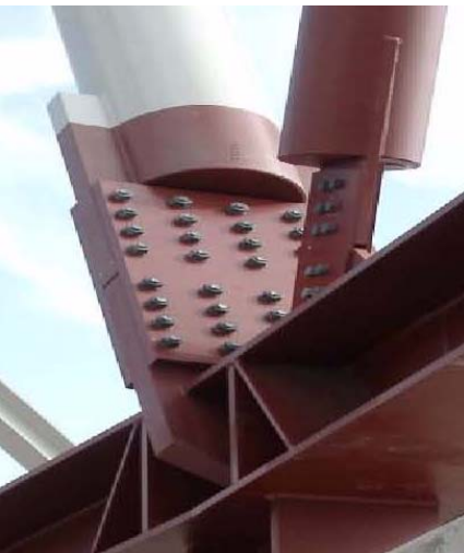
Bild 3. Ausführungsbeispiele - geschweißt (a) bzw. geschraubt. Teilbild 2d aus [1]
