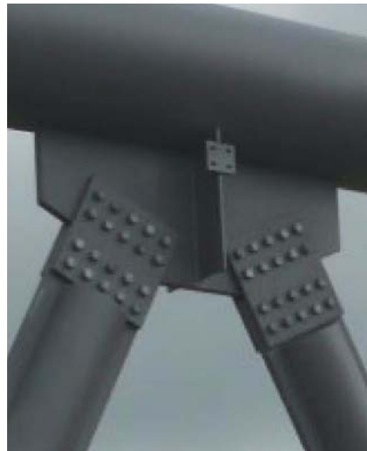
Bild 3. Ausführungsbeispiele - geschweißt (a) bzw. geschraubt. Teilbild 2d aus [1]
