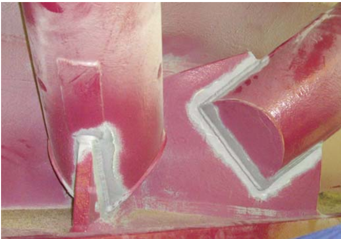
Bild 2. Hohlprofilstab mit außenliegenden Anschlussblechen (linkes Teilbild) und vereinfachte Erfassung des Tragverhaltens
