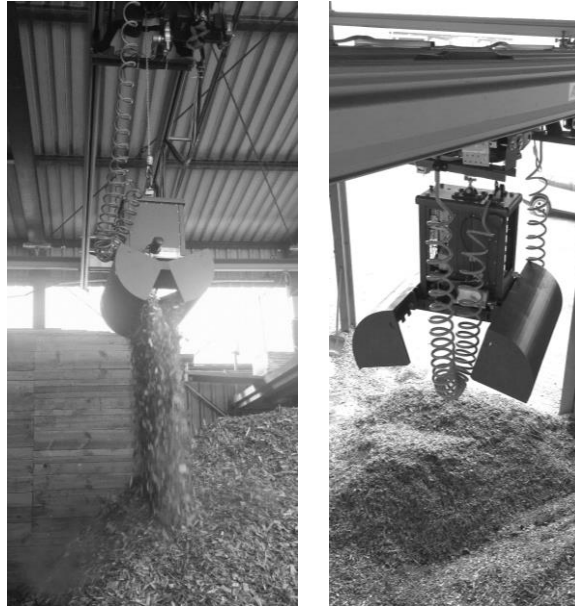
Abbildung 8: Prototypenanlage in Massing, Deutschland
